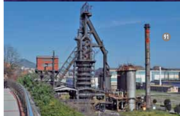
≈ Instalazioen ikuspegia, itsasadarretik, eta hiru labe garai 1980an. Labe bikiak, 1 zk.duna, 1959koa (behean, gaur egungo birgaitze-prozesua) eta 2 zk.duna, 1968koa, lehendik zeuden edukiera txikiagoko lau laberen ordean jarri ziren.
