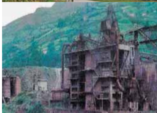
Labe horrek bete-betean funtzionatu zuen 1961etik 1975era. Burdinaren oxido karbonatua kiskaltzeaz arduratzen zen, araztasun hobeko mineral bat ekoizteko. Egunean 600 tona ekoizt zitzakeen.
