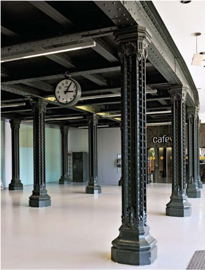
Bilbo-Concordiako geltokiko nasen egungo ikuspegia. Egia esan, terminaleko nasei zerbitzua ematen dien trenbideei eusten dieten metalezko biaduktuaren azpian dago. (Santi Yaniz)
