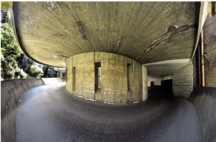
Arrapalaren barruko aldean, eraikuntza-sistemaren oinarriari eusten dio materialak. (Santi Yaniz)
