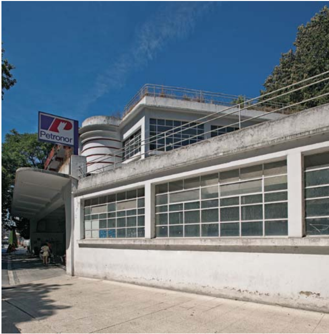
Gasolindegiaaren alboko ikuspegia; beirate luzeak ikus daitezke, harresiak ixten dituen metalezko muntaiarekin. (Santi Yaniz)
