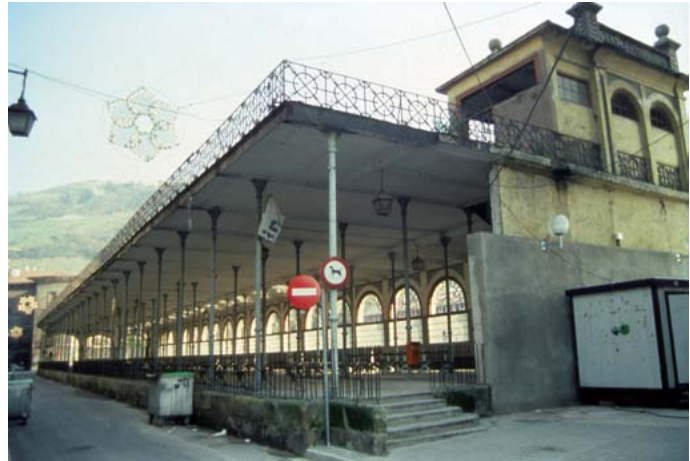
Burdinurtuzko egitura. Zutabeek harroin erraza zuen, baita goiko herenean eta kapitela piramidalean bolekin apaindutako eraztun modulatuak ere. ( Kultura Saila. Eusko Jaurlaritza ) Estructura de fundición de hierro. Las columnas contaban con una sencilla basa y anillo moldurado decorado con bolas en el tercio superior y capitel piramidal. ( Departamento de Cultura. Gobierno Vasco )
