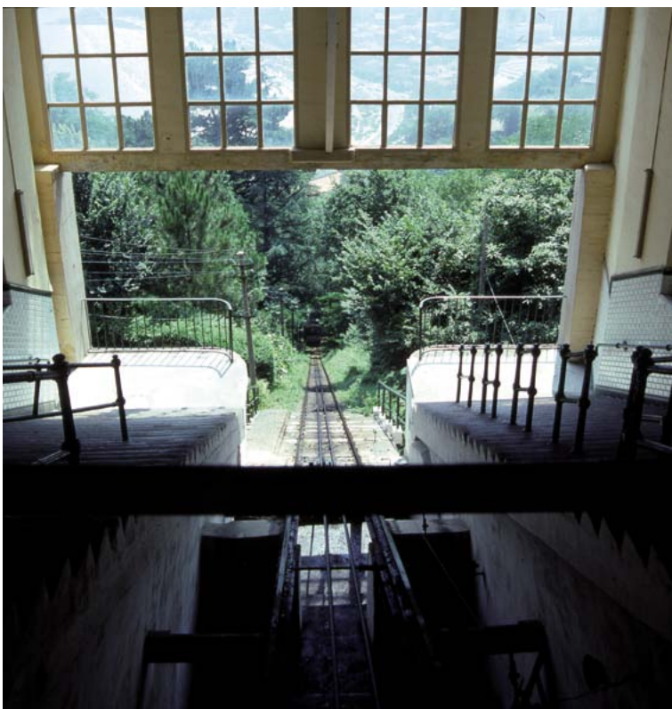
Egungo funikularrak 312,5 m-ko ibilbidea egiten du bide bakarrean, eta 151 m-ko desnibela gaintzen du. (AVPIOP/IOHLEE)
