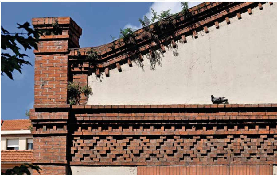
Fatxaden apaingarri multzoaren xehe-tasuna. Basurtuko adreilua frontoietan, frisoetan eta pilastretan. (Santi Yaniz)
