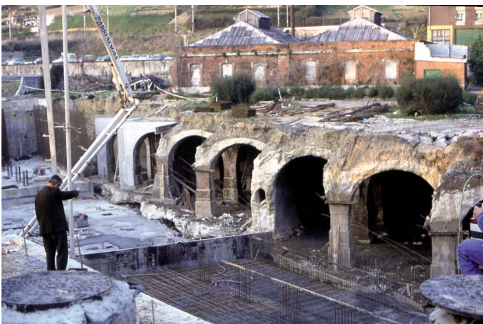
Zorrotaurreko biltegia metroko obrek moztua 1993an. (Joaquín Cárcamo) El depósito de Zorrotaurre seccionado por las obras del metro en 1993. (Joaquín Cárcamo)
