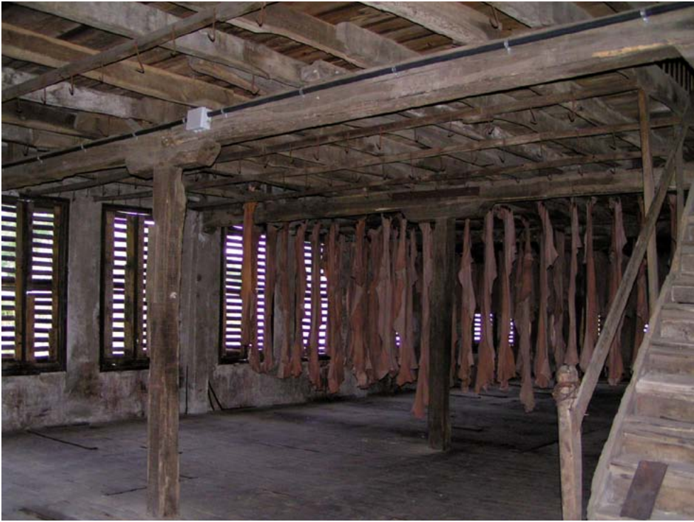
Bigarren solairuan kokaturiko lehortegi naturala. Fatxadako baoak zurezko lamekin eta itxierekin ixten dira kareletan; airearen giltza erregulatzea ahalbidetzen dute. Lurrean zuloak daude solairuen arteko komunikazioa errazteko. (AVIOP/IOHLEE)
