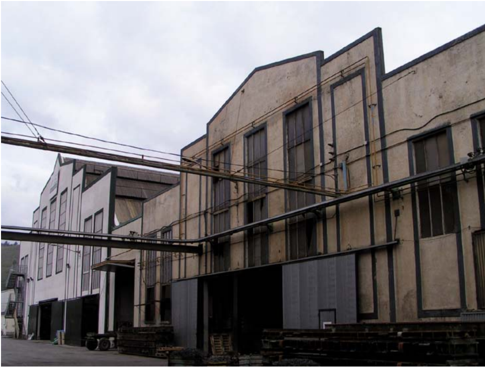
Metalezko egituraren produkzio nabea. Apaingarriak fatxada laburrean biltzen dira; errezel-harresia nabarmentzen da bertan, eta ardatz bertikala nagusi dituen bao zabalak daude. (María Romano)
