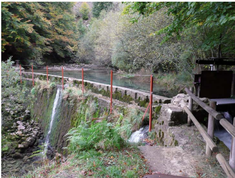
Sorburuko presa. Eskuinaldean, lehenengo tokian, argindarra ekoizteko berreskuraturiko ubidearen konporta. (Amaia Apraiz)
