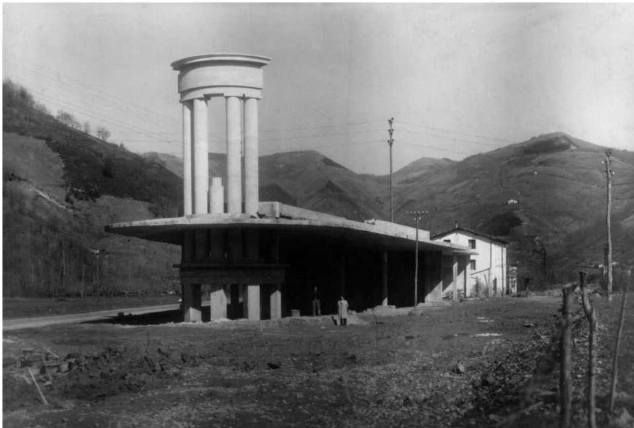
Lhurreko gasolindegia eraikitze lanetan. 1949 urtea. (José Iguain Telleriaren artxiboa) Gasolinera de lhurre en obras, año 1949. (Archivo José Iguain Tellería)
