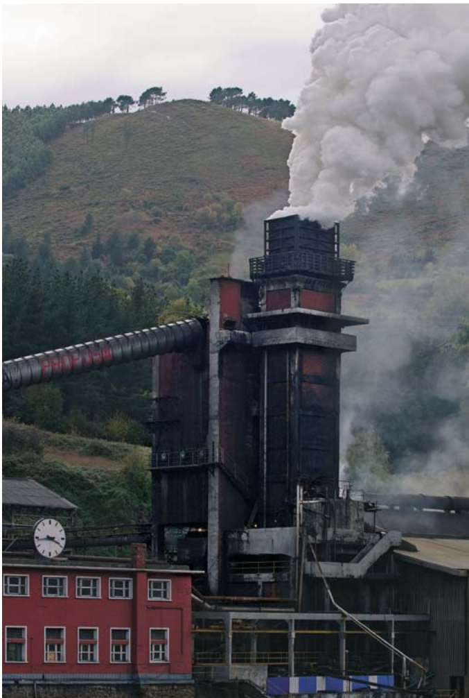
Bateriako labeen itzaltze-dorrea. (Santi Yaniz, 2009) Torre de apagado de coque de la batería. (Santi Yaniz, 2009)
