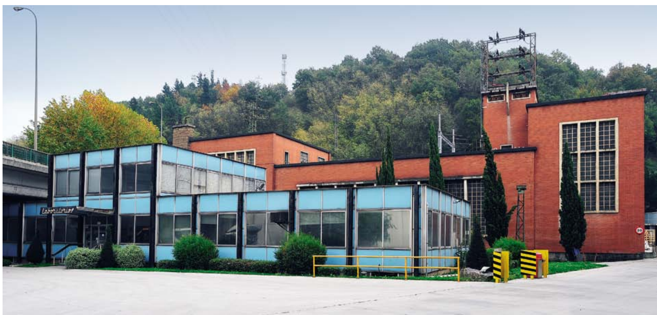
Fabrikako arkitektura osatzen duten adibide ezberdinak: lehen tokian, Laborategia, eta atzealdean, Zentral Elektrikoa. (Santi Yaniz)
