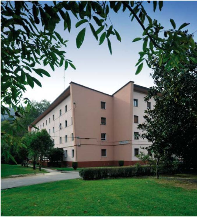
Alejandro Calonge etxebizitza multzoaren ikuspegi orokorra. (Santi Yaniz)
