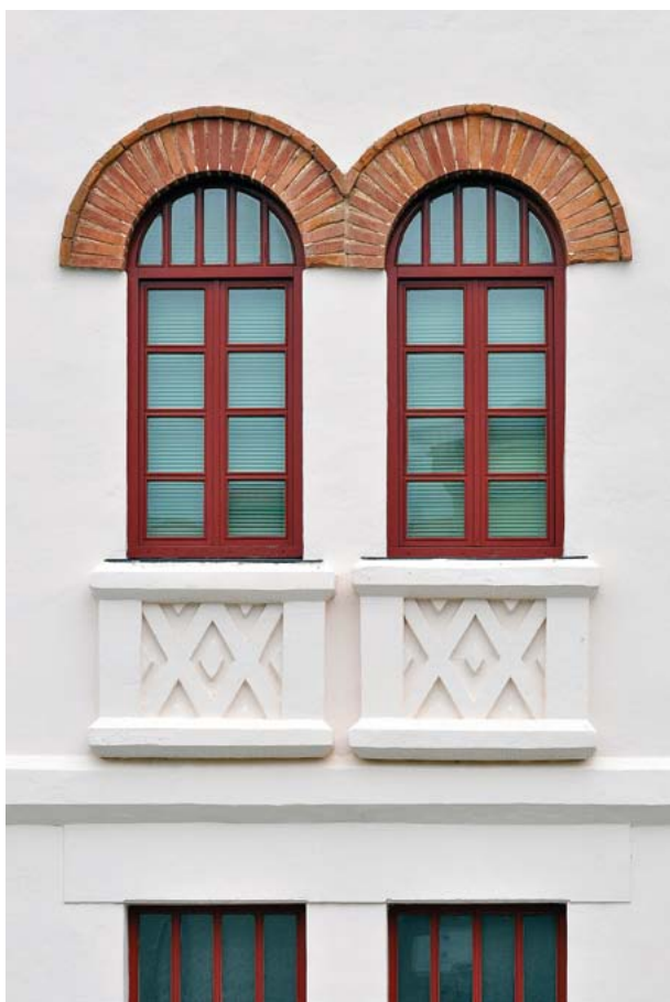
Maeztuko geltokiaren xehetasuna: leiho geminatuak. (Santi Yaniz) Un detalle de la estación de Maeztu: ventanas geminadas. (Santi Yaniz)
