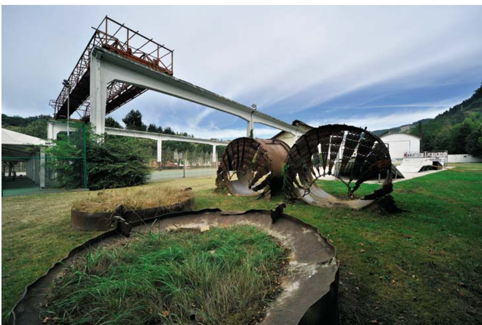
Txatarra parkearen kanpoaldea; gaur egun kirol instalazioa da. (Santi Yaniz) Exterior del parque de chatarra reconvertido en dotación deportiva. (Santi Yaniz)
