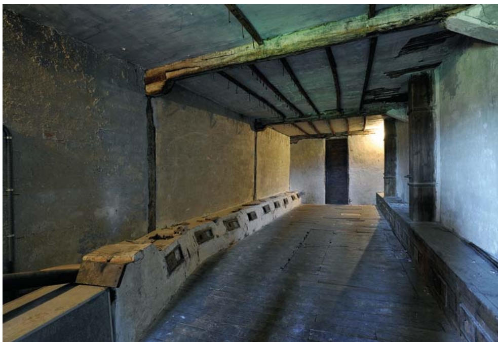
Bigarren solairuan kokaturiko lehortegi artifiziala. Hodiai sistema baten bidez iristen zen aire beroa beheko solairutik. Zuzeko eskuzko itxierekin erregulatzen ziren haize-bideak; fluxua kontrolatzen zuten. (AVPIOP/IOHLEE)
