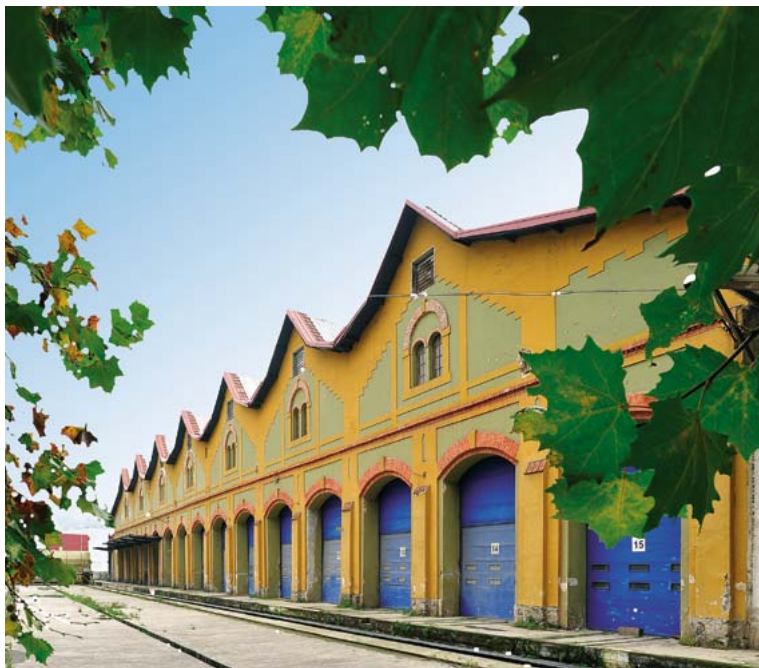
Muntaketa nabeen iparraldeko fatxada. (Santi Yaniz) Fachada norte de las naves de Montaje. (Santi Yaniz)
