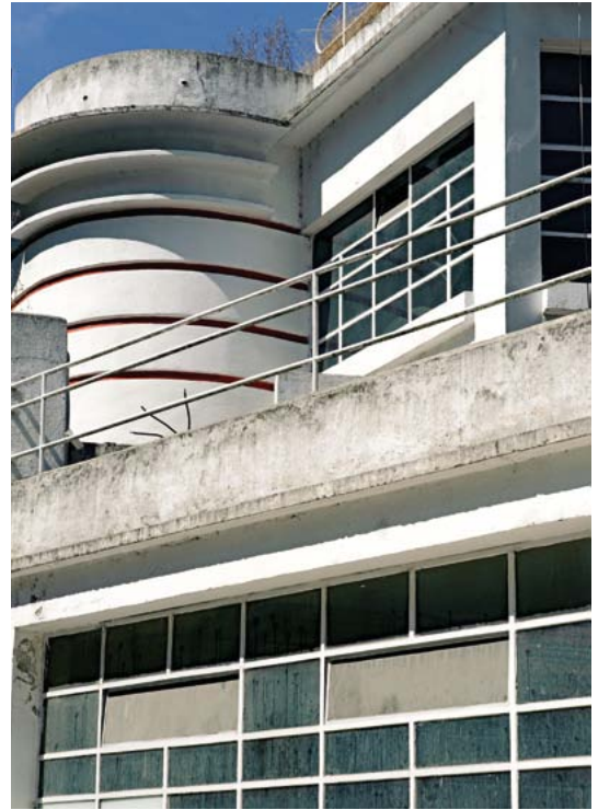
Gasolindegiaaren goiko solairuaren xehetasuna. (Santi Yaniz) Detalle de la planta superior de la gasolinera. (Santi Yaniz)
