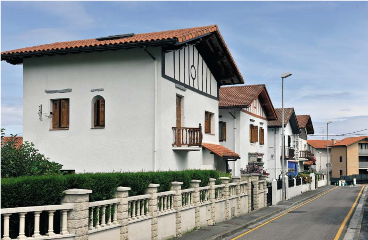
Kalean kokaturiko familia bakarrekotxetxebizitzak, estilo neo-erregionalistakoak. Horietako bakoitzak bi isurialdeko estalkia dauka, fatxada nagusiarekiko gailur perpendikularrekin. Berdegunea ere badu bai eta gune publikoa eta pribatua bereizten dituen hesia ere. (Santi Yaniz)
