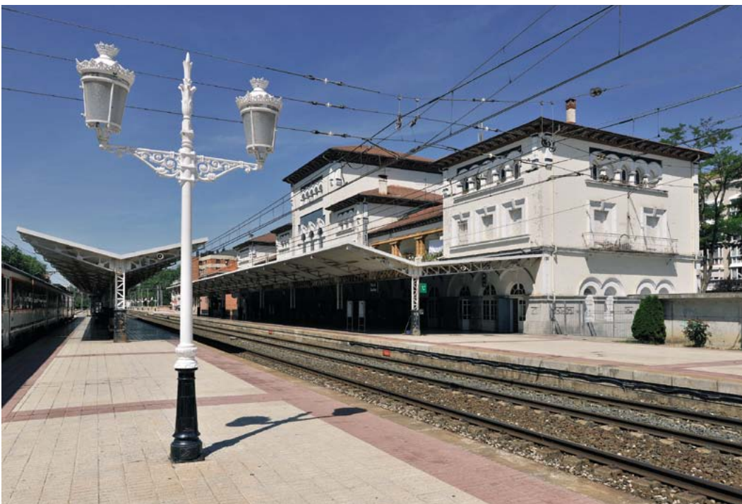
Gasteizko Compañía del Norte geltokiaren ikuspegi orokorra. (Santi Yaniz) Vista general de la estación de la Compañía del Norte en Vitoria-Gasteiz. (Santi Yaniz)
